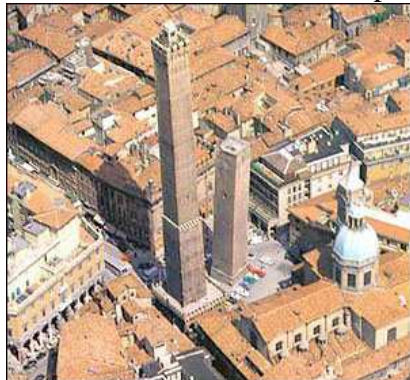
Le torri degli Asinelli e Garisenda
